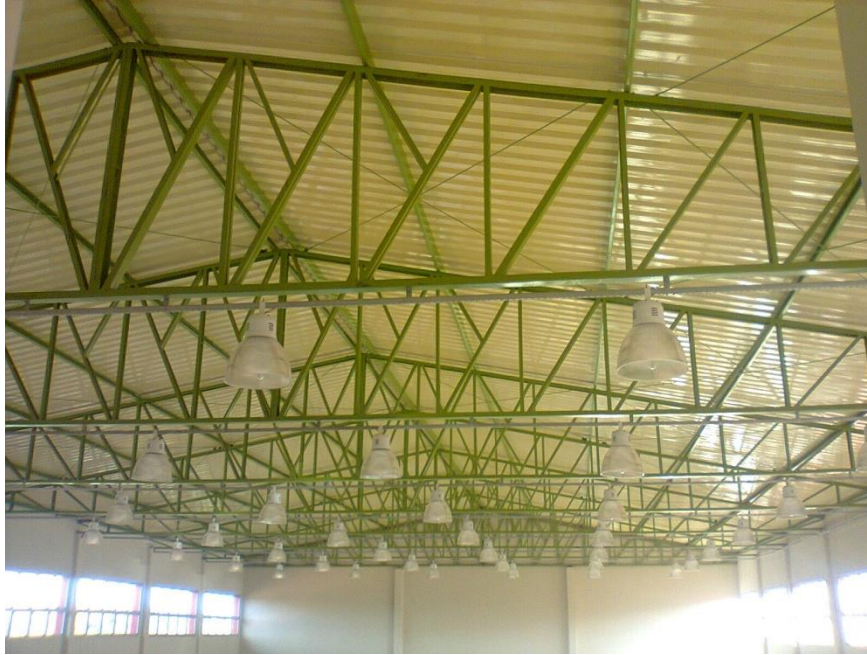
Figura: Treliça metálica no laboratório de edificações do IFSP Votuporanga. Fonte: O próprio autor.
